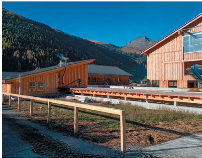
Technikgebäude. Fermenter unter Terrain begrünt
