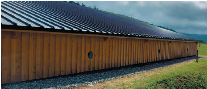
Fermenter mit Bullaugen zur visuellen Überwachung
